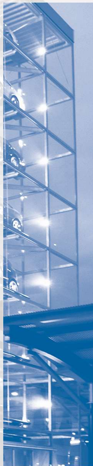
cartower bei der Firma S&G in Kehl
