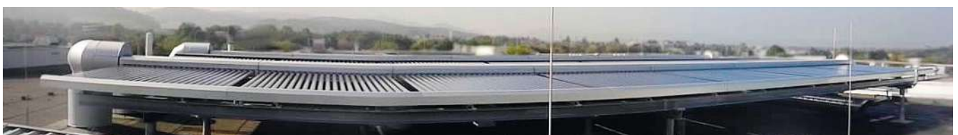
Abb. 3.2-5: Vakuumröhrenluftkollektorfeld der STAR1-Pilotanlage in Freiburg. Kollektoren des Typs Sun-Storm der Kollektorfabrik GmbH & Co. KG. Die Kollektoren sind horizontal (0°) auf dem Dach ausgerichtet. Die außenliegenden Luftkanäle sind isoliert
