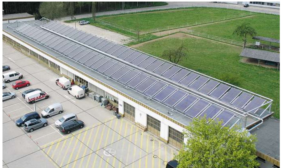
Abb. 3.1-1: Kollektorfeld der solaren Klimatisierungsanlage Rottweil
